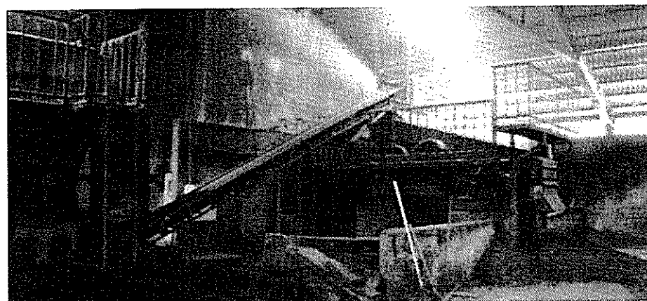
ペレット化施設 粉碎、ふるい選別後、水分を15%程度にしてからペレット化する。
