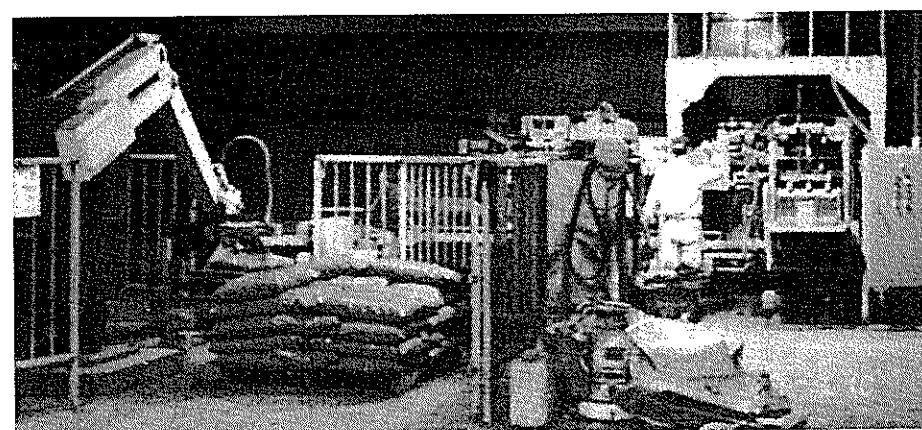
ペレット化・袋詰め施設 製品の9割以上はペレット化されて、袋詰めされる。
