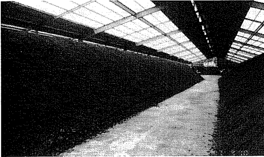
主発酵施設 発酵促進剤を混合したのち、2週間おきに4回切り返す。左側のパイルの底部にはブロワーが設置されている。
